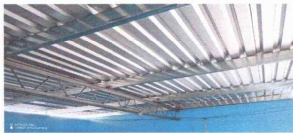
Foto 2: SE OBSERVA COSTANERAS NUEVAS INSTALADAS EN MODULO NO.1
