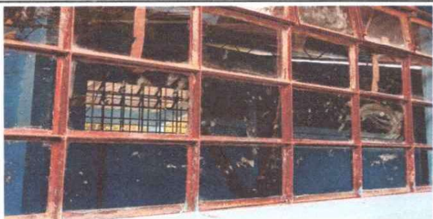
Foto 3: SE OBSERVA VIDRIOS INSTALADOS EN MODULO NO.2 y 3
