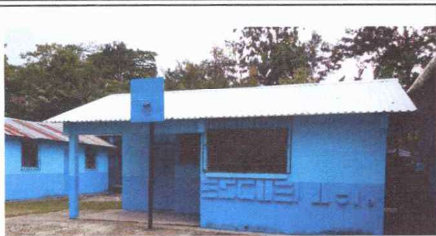
Foto 1: SE OBSERVA EL TRABAJO DE SUSTITUCION DE LAMINAS Y APLICACIÓN DE PINTURA EN LAS PAREDES TERMINADA EN MODULO NO.1
