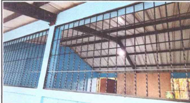
Foto 4: SE OBSERVA BALCONES CON SU MANTENIMIENTO PINTURA TERMINADA DE LOS MODULOS 1, 2 Y 3.
